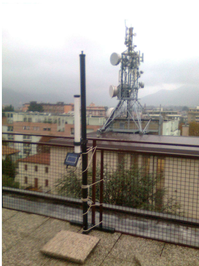
Figura 2 – Foto della centralina sulla posizione di misura, sullo sfondo il traliccio delle antenne.
